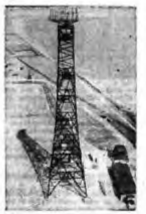
Vista delle torri di radiolocalizzazione sulla costa inglese. Queste stazioni avevano il compito di segnalare gli aerei nemici che si avvicinavano a volo radente. L'altezza delle torri è di circa 200 metri.
