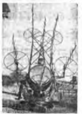
Proiettore convenzionalmente controllato da apparecchiature di radiolocalizzazione. Tutto il complesso è azionato e comandato a distanza dall'aereo nemico, una volta individuato, è seguita nelle sue evoluzioni.
