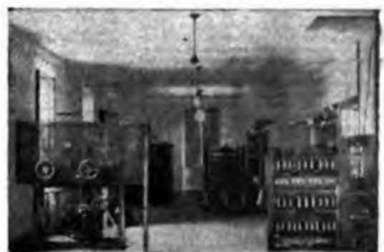
Roma (S. Palomba): la nuova stazione da 100 kW
