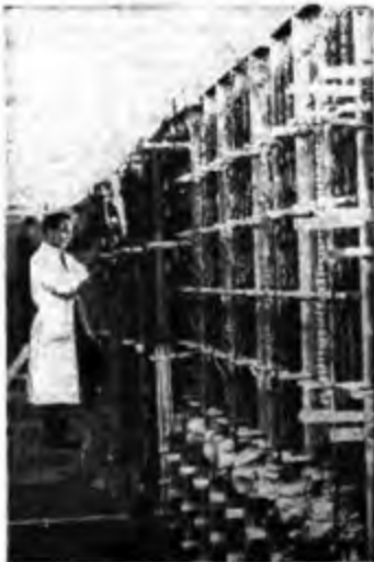
Torino: impianto di bassa frequenza
