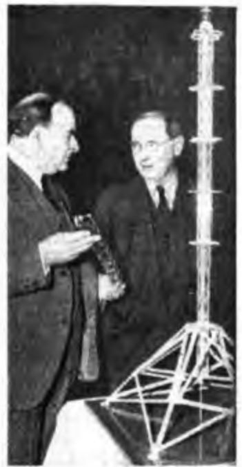
Modello di antenna allo studio negli Stati Uniti d'America, specialmente adatta per le trasmissioni ad onde ultracorte con modulazione di frequenza. L'antenna è in realtà alta pochi metri. Lo spazio fra gli elementi in figura è uguale a un mezzo di lunghezza d'onda rispetto ai metri.
