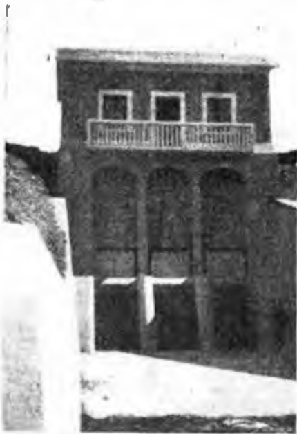
Impianti del Mantegna: la diga di San Nicolao
