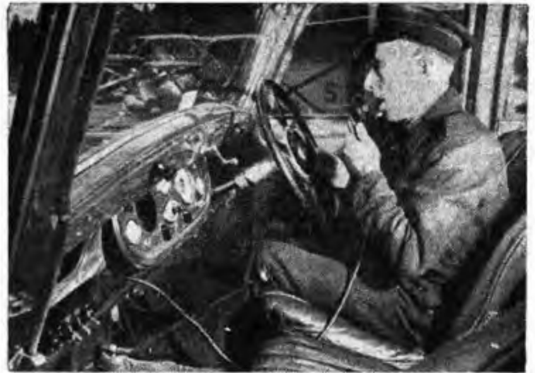
Fig. 1 - Installazione su automezzo di un trasmettitore per comunicazioni " Multi-carrier ..
