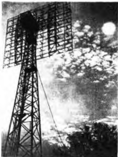
La stazione per gli esperimenti di collegamento fra la Terra e la Luna a mezzo del « radar ».
