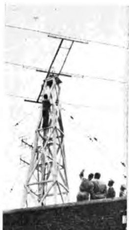
Un nuovo tipo di antenna a raggio rotante di costruzione americana per il collegamento con gli aerei in volo.
