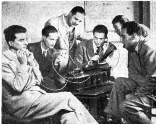
Questo «ciclope» di meccanica è un fonografo inventato da Thomas Alva Edison nell'anno 1878-1888. Vero capolavoro dell'epoca, funziona elettricamente, l'audizione viene fatta a mezzo di tubi di gomma applicati a speciali pipette di ebanite.
