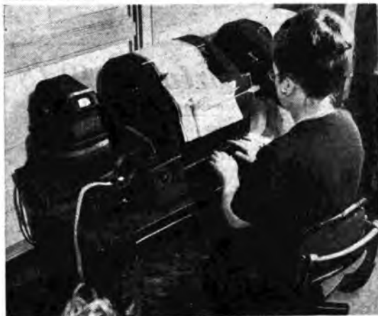
Nuove applicazioni della radio (dall'alto in basso): Una cabina di comando per gli scambi ferroviari azionati a mezzo radio in una stazione francese; la cabina è collegata radiofonicamente anche con le locomotive in manovra, le quali ricevono così esatte istruzioni di movimento - Il complesso impianto di un calcolatore elettronico, che funziona presso l'Ufficio Internazionale Scientifico di New York; esso consente una velocità di esecuzione nelle operazioni matematiche 250 volte maggiore di quella delle normali macchine calcolatrici - Per mezzo di una teleselezione l'Ufficio Postale delle Nazioni Unite, a New York, mantiene il più rapido collegamento possibile con ogni parte del mondo.
