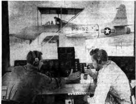
Avieri istruttori che controllano il funzionamento pratico di un apparecchio a reazione. L'item, che si vede, è uno « Shooting Star » solidamente fissato al suolo da incastellature in cemento.
