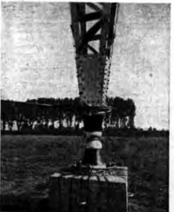
Base dell'antenna. - Il suo isolamento elettrico verso terra è ottenuto, come si vede dalla fotografia, da due grandi isolatori in porcellana, poggianti l'uno sull'altro con nodo sferico.
