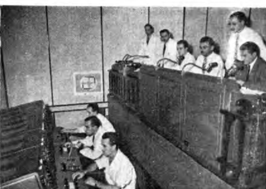
La sala regia per la televisione. In alto è il banco di controllo per le operazioni di mixaggio. Sono visibili: a destra, il posto del regista; al centro, il posto « video » per il controllo delle immagini; a sinistra, il posto « audio » per il controllo del sonoro. In basso: i posti di controllo delle telecamere e della macchina cinematografica.
