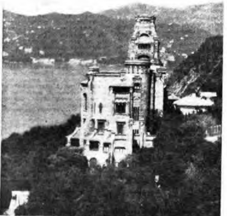
Il castello di Sem Benelli a Zoagli, costruito dall'architetto Mancini.
