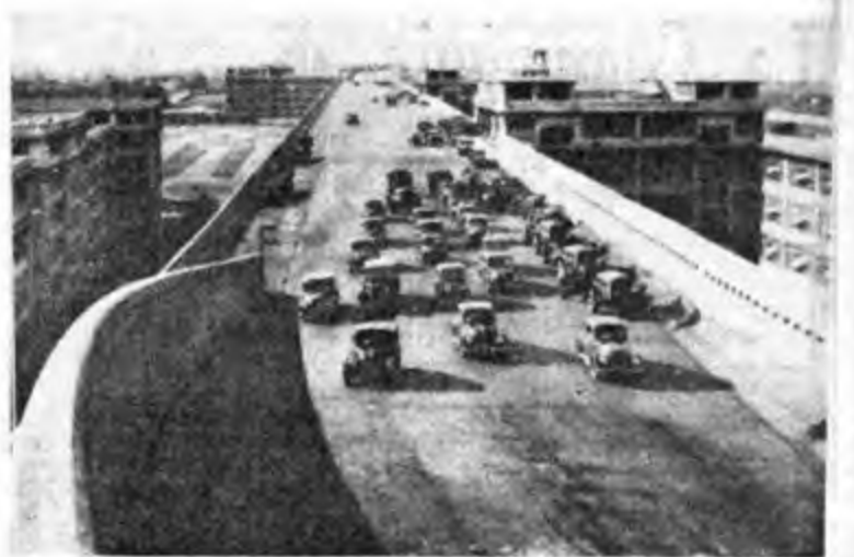
◆ Lo stabilimento del Lingotto fu costruito subito dopo la prima guerra mondiale: lungo mezzo chilometro, largo 80 metri, alto 27, porta sul tetto una pista di oltre 1 chilometro di sviluppo, buona per ogni portata e velocità. E' tuttora in funzione.
