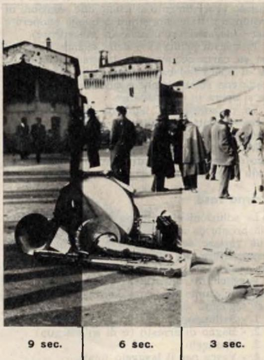
**Fig. 6 - Esponendo successivamente tre uguali settori di un negativo con tempi diversi si ottiene una stampa di prova che indicherà l'esatto tempo di esposizione per una giusta densità.**
