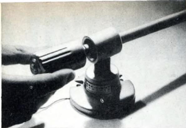
Il contrappeso è tenuto in posizione nel braccio Rek-o-Kut da una vite interna caricata da una molla. Un solo giro del contrappeso fa variare esattamente di mezzo grammo la pressione della puntina sul disco.
