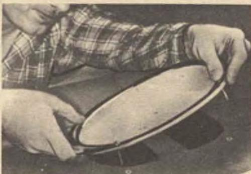
**Saldate l'estremo libero del filo rosso ad un capo della bobina mobile dell'altoparlante anteriore e l'estremo del filo bianco ad un capo della bobina mobile dell'altoparlante posteriore. L'altro capo di ciascuna bobina sarà collegato a massa. Prima di collaudare controllate ancora il vostro impianto.**
