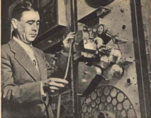
(A sinistra) Il primo registratore video a colori fu presentato dalla RCA nel 1953. Il nastro scorreva ad una velocità di 600 m/sec. Un rotolo di 8 cm di diametro è richiesto per registrare un programma di 15 minuti. (Sotto a sinistra) Una veduta d'insieme della sala di registrazione video della CBS Television City di Hollywood. (Sotto a destra) Uno speciale apparecchio smagnetizzatore « cancella » automaticamente il nastro in pochi secondi. Il nastro è utilizzabile per circa 200-registrazioni.
