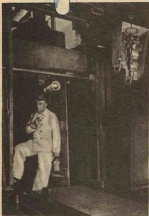
**P**er eliminare le spese e i possibili guasti di un ordinario sistema di comunicazioni telefoniche tra superficie e sottosuolo di una miniera, una ditta tedesca (la Standard Elektrik di Stoccarda) ha adottato un nuovo metodo usando il cavo di sollevamento dell'ascensore come avvolgimento secondario di un trasformatore. L'uscita di un microfono, nella cabina di comando in superficie, viene amplificata e immessa nel primario del trasformatore che è elettromagneticamente ac-
