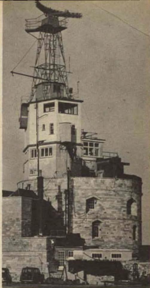
Dispositivo di esplorazione di 8 metri del tipo Decca 31 per impianto radar portuale montato sulla torre di Calshot.
