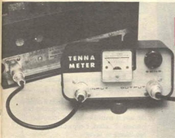
Questo strumento che funziona da monitor di controllo di modulazione è lasciato sempre inserito sulla linea.
