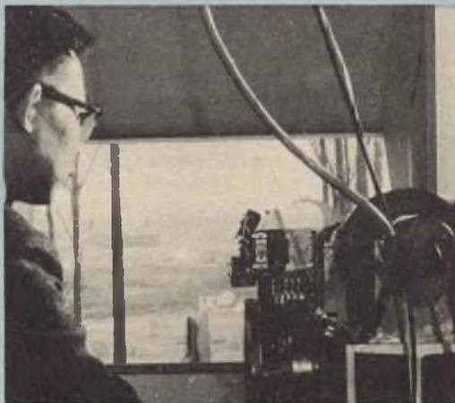
**S**cintillante come una stella la luce laser attraversa uno spessore d'aria di più di 1.500 metri. Nella foto si scorge lo scienziato Ta-Shing Chu che studia, presso i laboratori della Bell situati a Holmdel nel New Jersey, l'attenuazione del fascio laser provocata dalla pioggia (30 dB) e dalla nebbia e neve (80 dB). In considerazione di tali attenuazioni sarà probabilmente necessario far passare i sistemi di comunicazioni laser attraverso speciali "tubi ottici" sotterranei.
