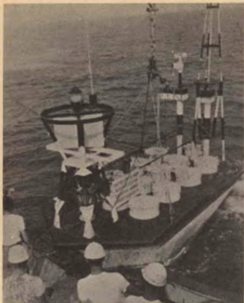
Questa stazione meteorologica galleggiante, sistemata su una boa al largo del Golfo del Messico, viene alimentata con energia atomica.
