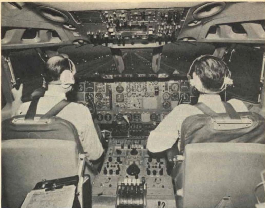
Fig. 2 - Ecco come appare il posto di comando del reattore di linea Super VC10 G-ASGG mentre effettua un atterraggio automatico « senza mani » nell'aeroporto delle Royal Aircraft Establishment.
