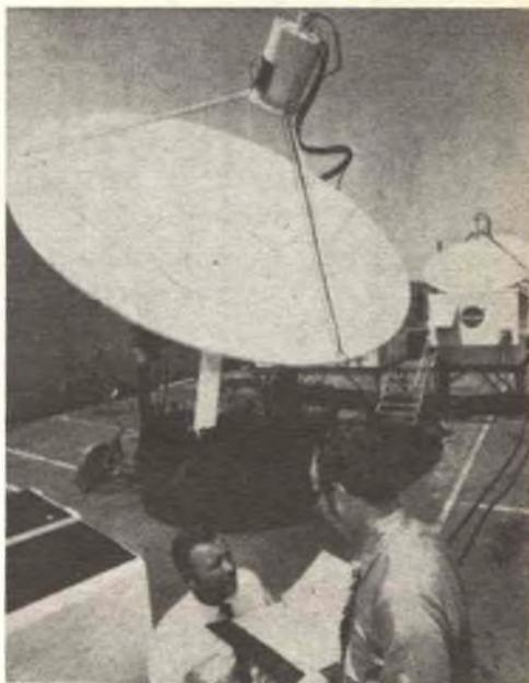
*La nuova stazione terminale a terra per satelliti è composta da un disco di 6,5 m (in primo piano), da un disco di 4,5 m e da apparati elettronici montati in appositi furgoni.*
