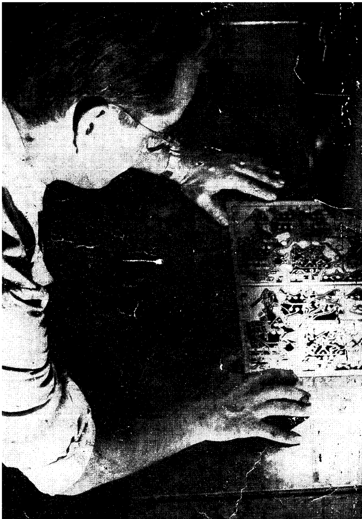
Obr. 54. Příprava klišé se základním materiálem k expozici
