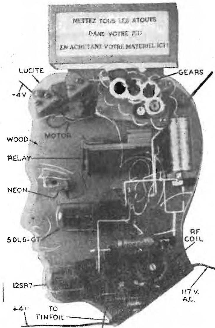
un pezzetto di legno che, quando il relè attrae l'ancoretta, scopre un foro posto in corrispondenza dell'occhio e dietro al quale è sistemata una lampada al neon accesa tramite un trasformatore d'uscita per altoparlanti, collegato alla bobina mobile di un ricevitore. L'alimentazione è ottenuta con CA non rettificata, direttamente dalla rete di alimentazione.
