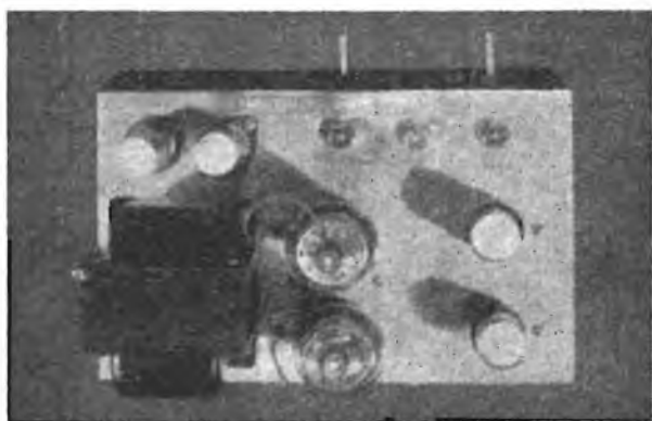
La foto mostra la disposizione dei componenti sul telaio dell'amplificatore. L'alimentazione è montata su un telaio separato onde diminuire la possibilità di ronzii.
