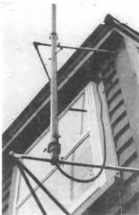
La foto mostra il particolare del fissaggio dell'antenna descritta al muro.
