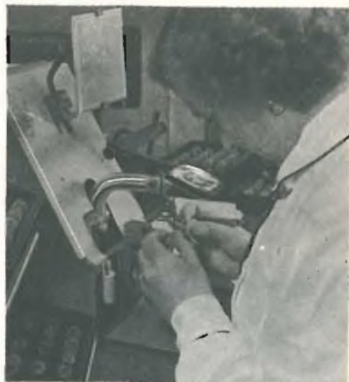
Il "pacchetto" viene saldato sugli elettrodi del fondello mediante il calibro di "montaggio pacchetto su fondello" per far sì che le connessioni di tutti gli elettrodi risultino perfettamente uguali.
