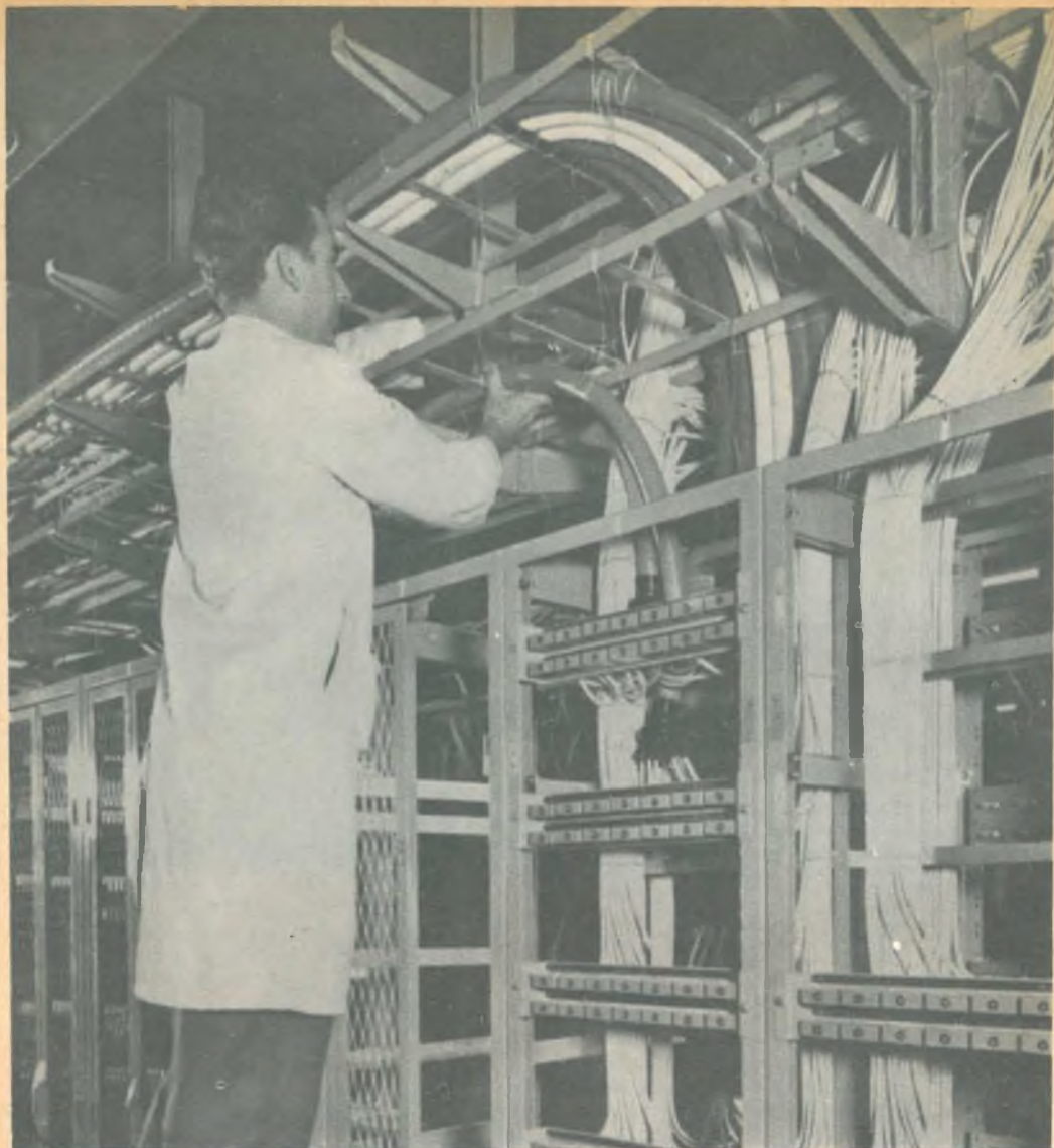
Alcuni cavi coassiali per il trasporto del segnale video dalle telecamere alla sala di regia o al trasmettitore.
