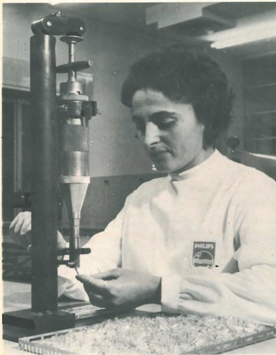
Preparazione dei palloncini di vetro per un tipo di transistor.
