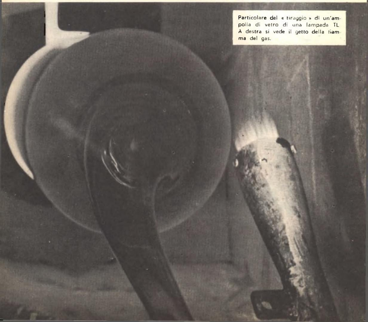
Particolare del « tiraggio » di un'ampolla di vetro di una lampada TL. A destra si vede il getto della fiamma del gas.
