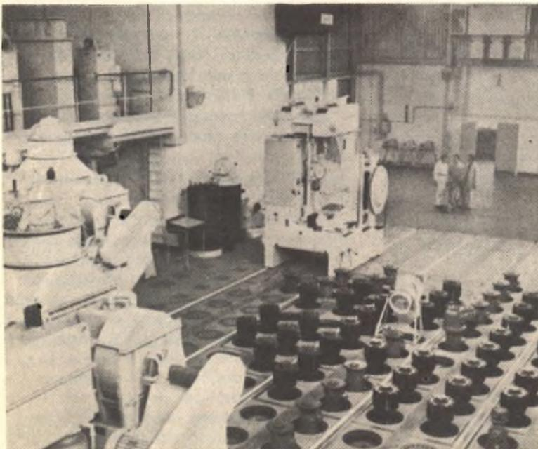
Veduta generale del piano di caricamento del reattore N. 1 dell'impianto di produzione dell'energia nucleare di Calder Hall; si vede anche una macchina per il caricamento e lo scarico.
