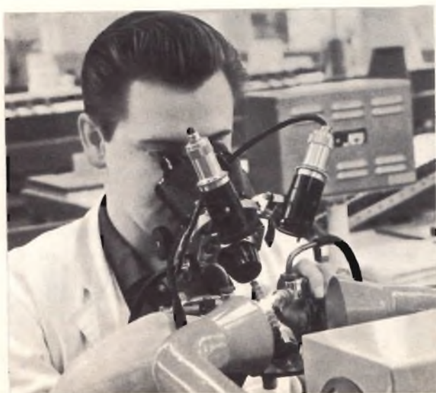
Mascheratura dei transistor RF a lega e a diffusione.
