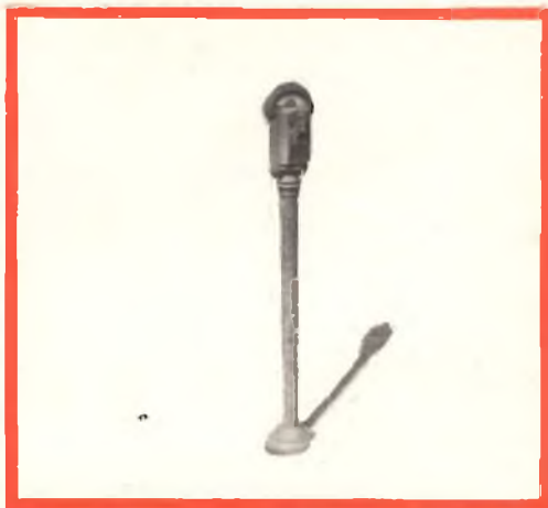
Fig. 1 - Aspetto del parchimetro descritto, installato sul bordo di un marciapiede. Nella foto è visibile anche una parte del cofano di un'autovettura, che mette in evidenza la distanza alla quale l'apparecchio risulta ancora abbastanza sensibile agli effetti dell'azzeramento automatico.
