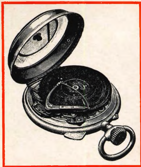
Orologio con incorporato un grammfono, il disco contiene 48 solchi.
