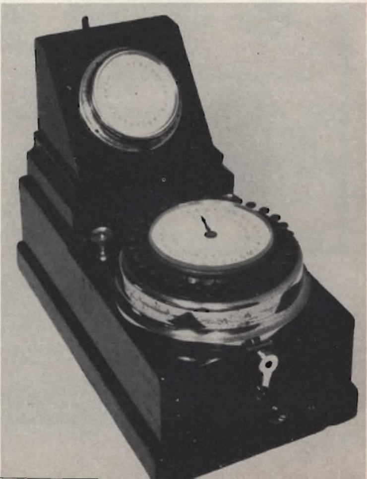
Fig. 13 - Telegrafo A.B.C. di Wheatstone (1858). Come quello della fig. 11, esso utilizza un meccanismo passo-passo, ma molto migliorato. In trasmissione l'operatore girava costantemente la manovella che provocava la trasmissione di una serie continua di impulsi di corrente. Per trasmettere una data lettera, l'operatore premeva sul pulsante corrispondente; questo faceva spostare gli indici alle due stazioni, sotto l'influenza degli impulsi di corrente, nel senso delle lancette di un orologio fino a che questi si fermavano di fronte alla lettera scelta. Questa forma d'apparecchio è restata in funzionamento in certi distretti rurali della Gran Bretagna fino al 1920.
