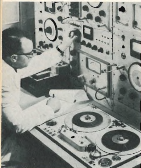
Fig. 9 - Banco di prova per la verifica delle proprietà del nastro magnetico.
