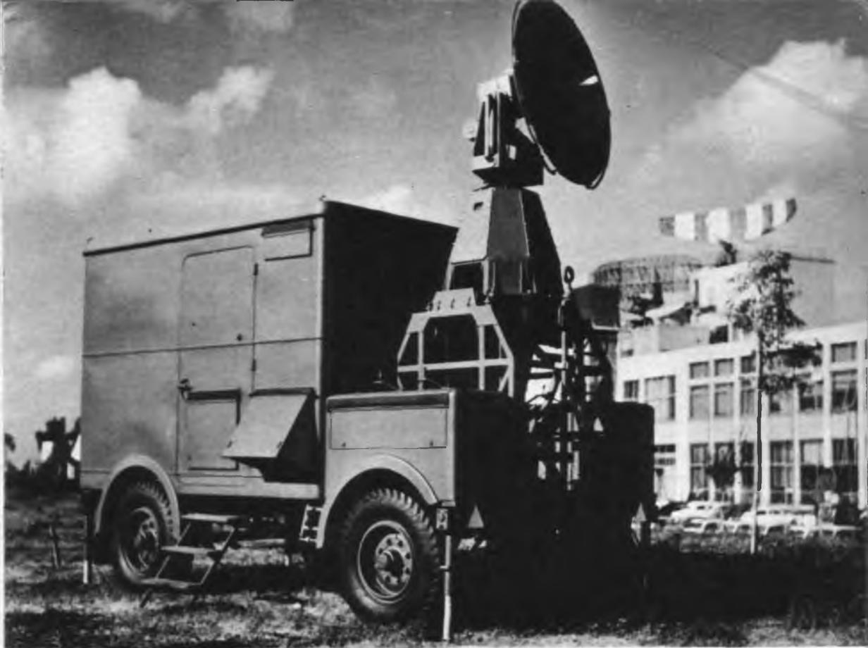
Fig. 1 - Radar meteorologico Selenia RMA - 1c montato su autocarro.
