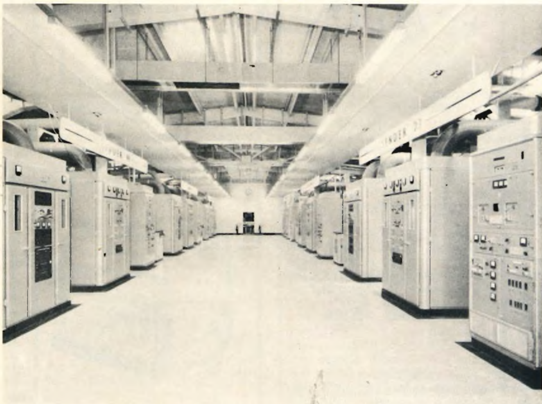
Fig. 4 - 6 trasmettitori Marconi da 250 kW su onde corte in servizio presso la stazione radio della BBC
