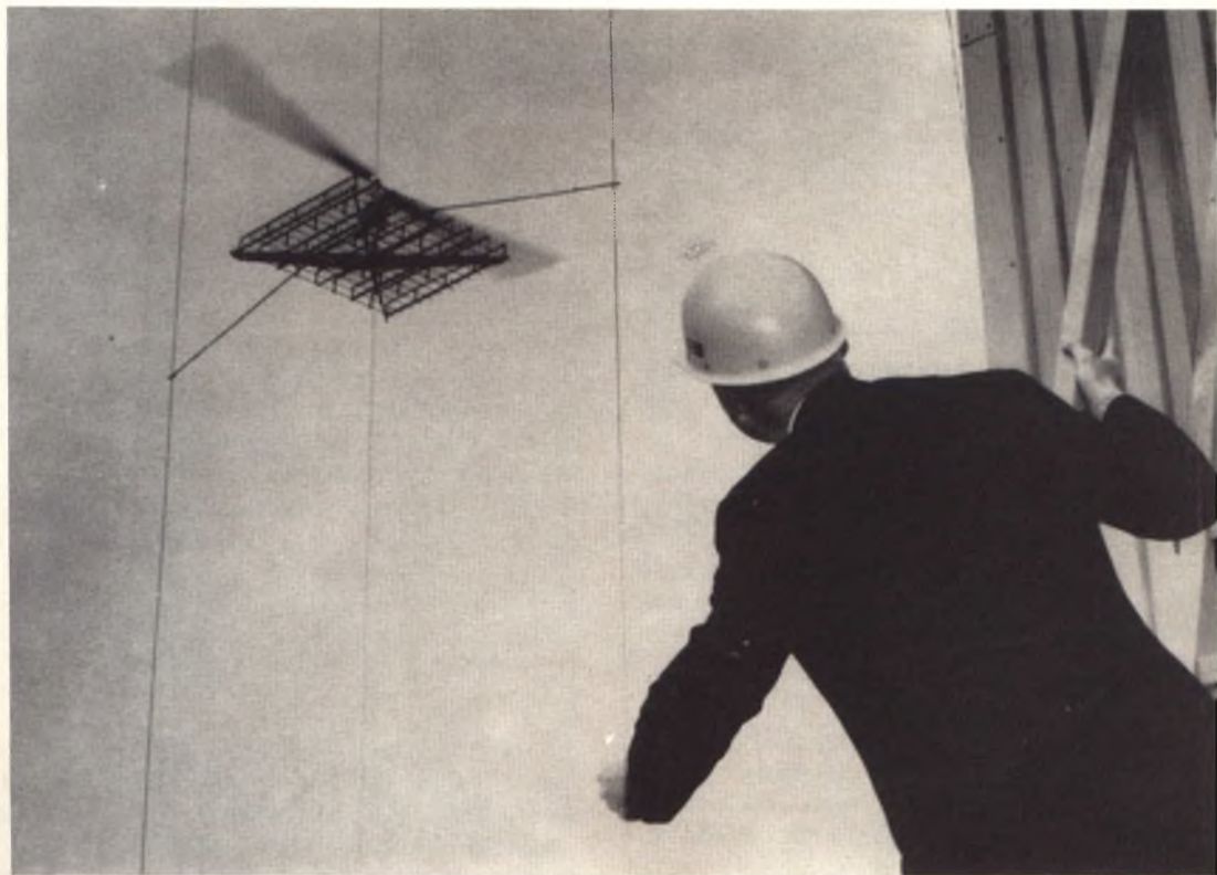
Fig. 10 - Esperimento riuscito! L'elicottero vola, utilizzando la sola energia fornitagli dal trasmettitore microonde.
