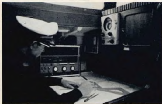
Fig. 2 - Il ricevitore SONY CRF-230 World-Zone impiegato come apparecchio ausiliario a bordo di una nave.
