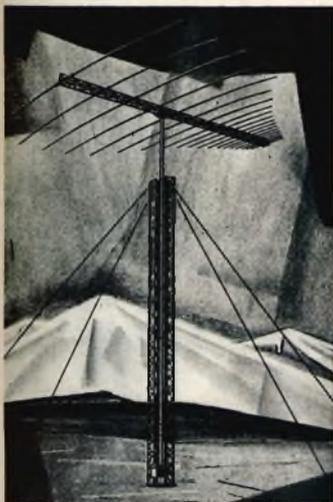
Fig. 4 - Antenna Hy-gain da 4-30 MHz, logaritmica periodica.
