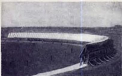
Fig. 7 - Il grande radiotelescopio dell'Osservatorio di Pulkovo nell'Unione Sovietica. Sensibilità in flux  $10^{-29}$  W/m<sup>2</sup> Hz e risoluzione dell'ordine di 1 secondo d'arco.
