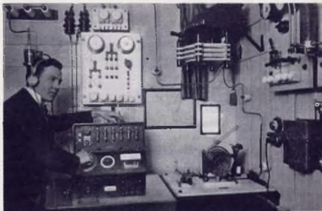
Fig. 1 - Stazione radio di una nave passeggeri del 1921. Sono chiaramente visibili in basso i reostati di avviamento ed in alto lo spinterometro a dischi.
