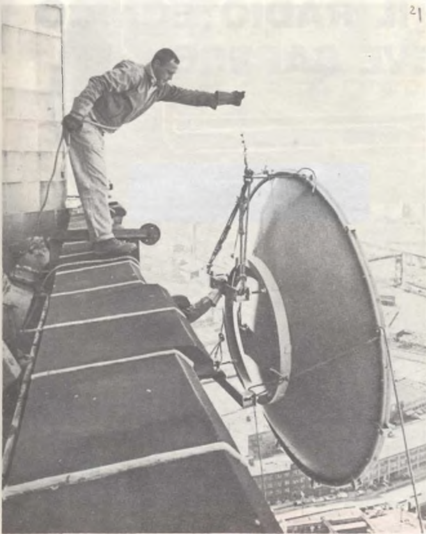
Fig. 2 - Installare un'antenna parabolica a 100 m di altezza? Ma è una cosa semplicissima, basta non soffrire di vertigini!
