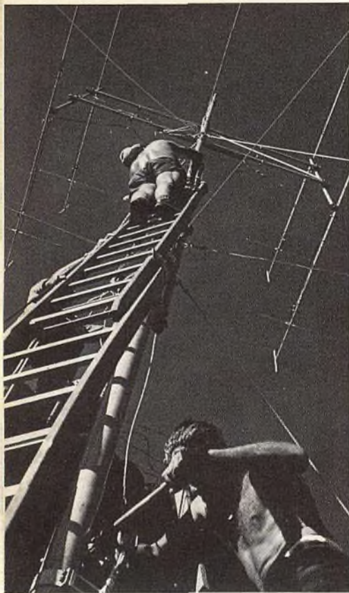
Figg. 3-4 - Fasi di montaggio dell'antenna HB9SV particolarmente delicate in cui necessitano stabilità d'appoggio base, controventatura a mezzo tiranti a scivolamento e molta fatica di braccia.
