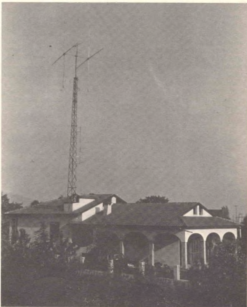
Fig. 1 - Ecco il QTH di I2AMC in via Prinetti a Merate. Spicca al centro della casa il pilastro, incorporato nelle strutture, sul quale è stato fissato il traliccio. Questo regge in sommità una «Quad» tribanda ed una YAGI per i 144; nello stesso tempo fa da supporto a varie antenne filari e direttive per i 144 e 432 MHz.
