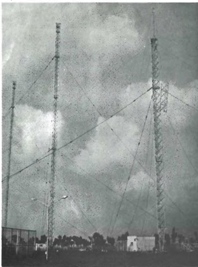
Fig. 8 - Installazione dell'ultimo tronco dell'antenna di Roma S. Palomba (1331 kHz). A sinistra gli altri due piloni già terminati.
