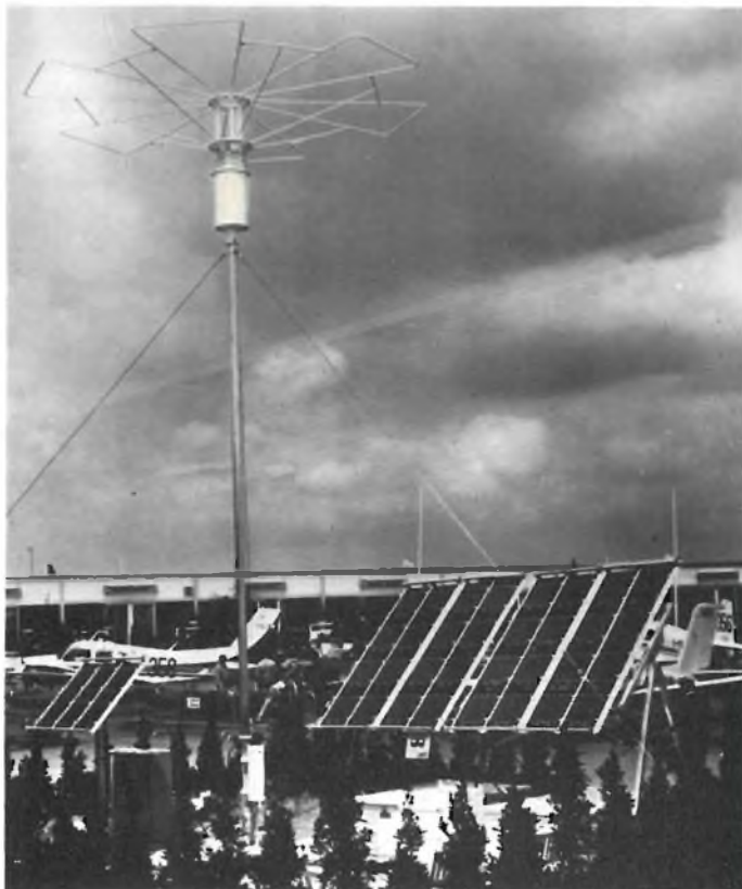
Fig. 1 - Installazione per lo sfruttamento dell'energia solare per alimentare apparati di telecomunicazione. Il pannello sulla destra contiene 32 moduli BPX 47 mentre quello piccolo ne contiene 6 (RTC-Philips).
