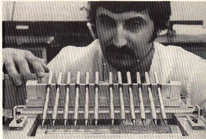
Fig. 15 - Un ingegnere dell'RCA mentre aggiusta la macchina che serve a tagliare e a dar forma alle puntine di zaffiro. I piccoli tubi sostengono le puntine mentre il cilindro rotativo le mola.
